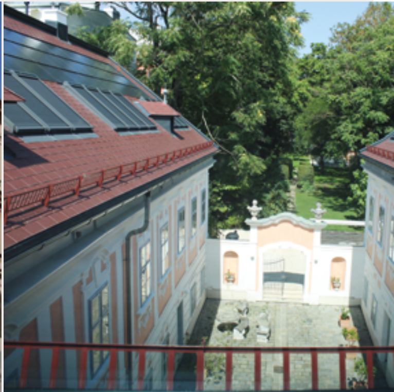
PV-Elemente am Dach der Hoftrakte
