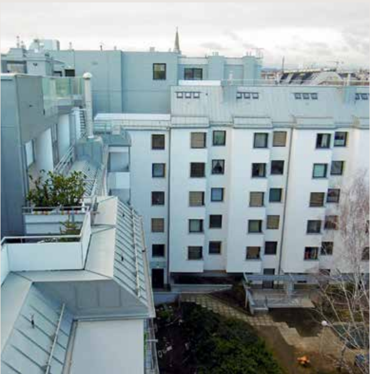
Innenhof nach Sanierung
