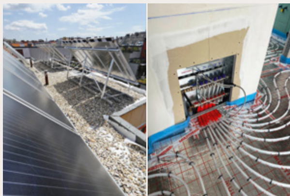
Wärme- und Stromversorgung basierend auf Solar- und Geothermieenergie
