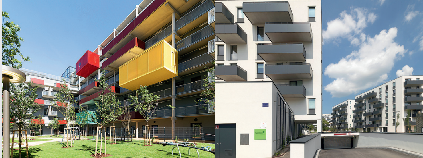
10., Sonnwendviertel, BAUPLATZ B.04 SÜD
